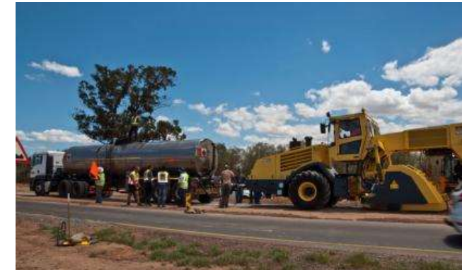
Die Fräse schiebt den LKW mit Emulsion
