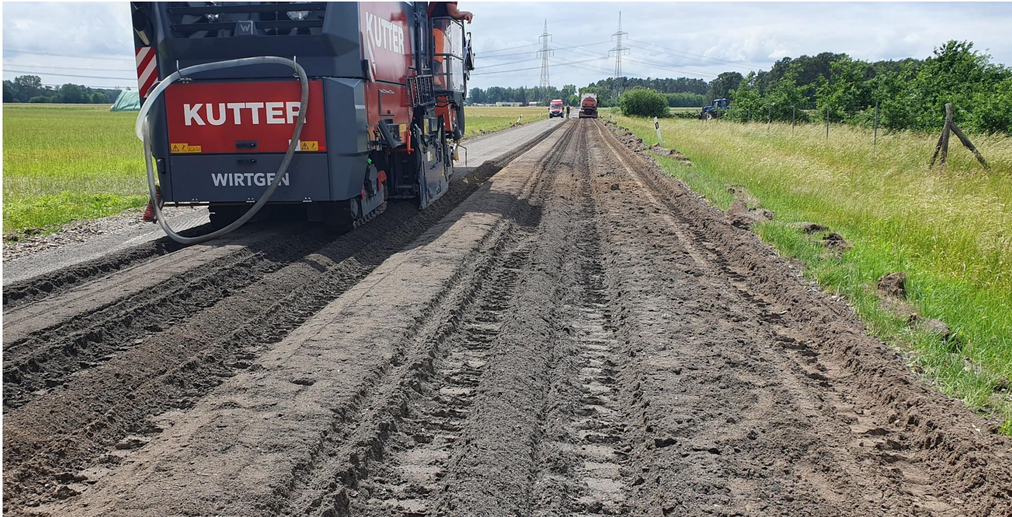
Durchfräsen der restlichen Asphaltbefestigung mittels Kaltfräse
