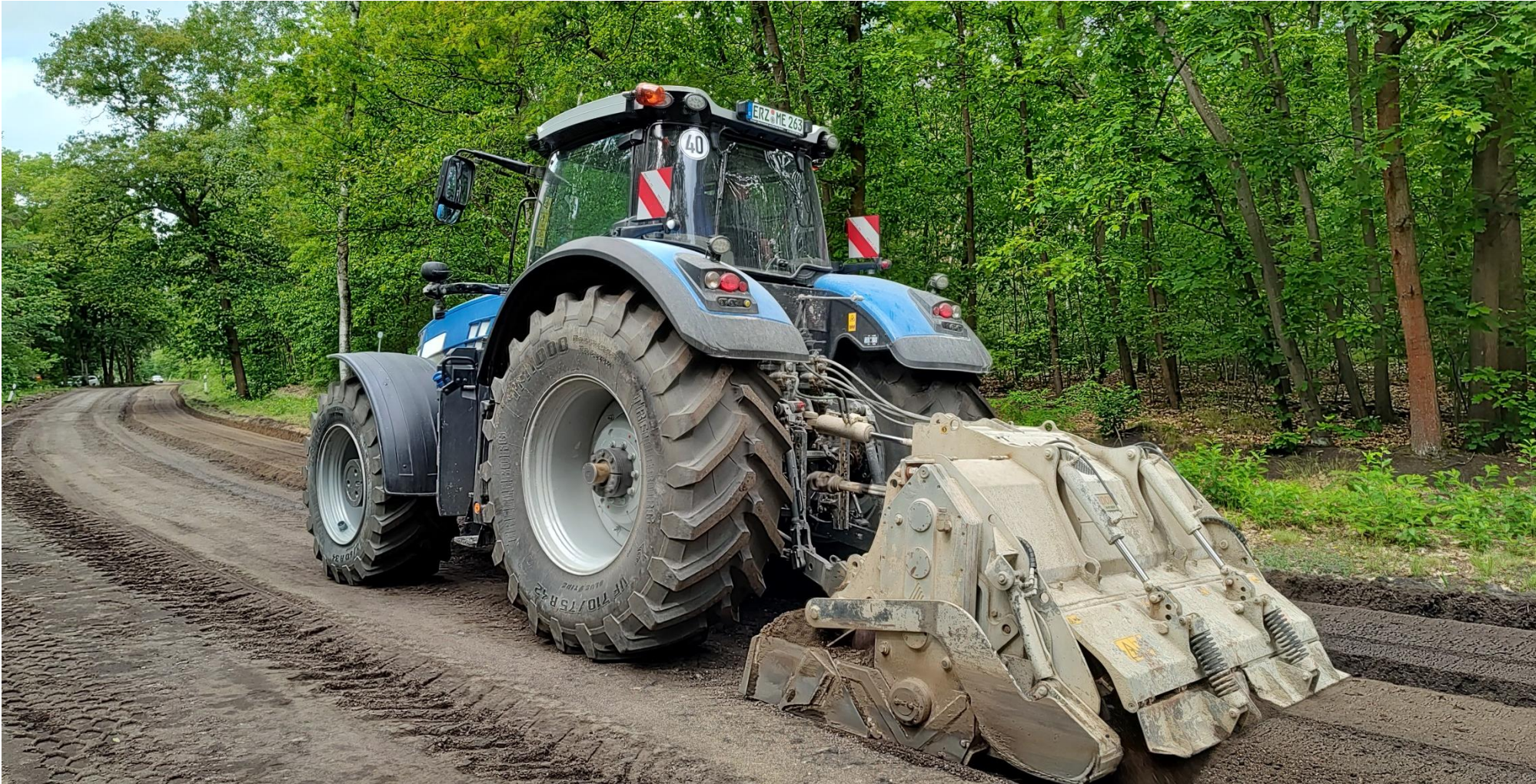
Nachbrechen der durchgefrästen Asphaltbefestigung mittels Traktor mit angehängter Brechvorrichtung
