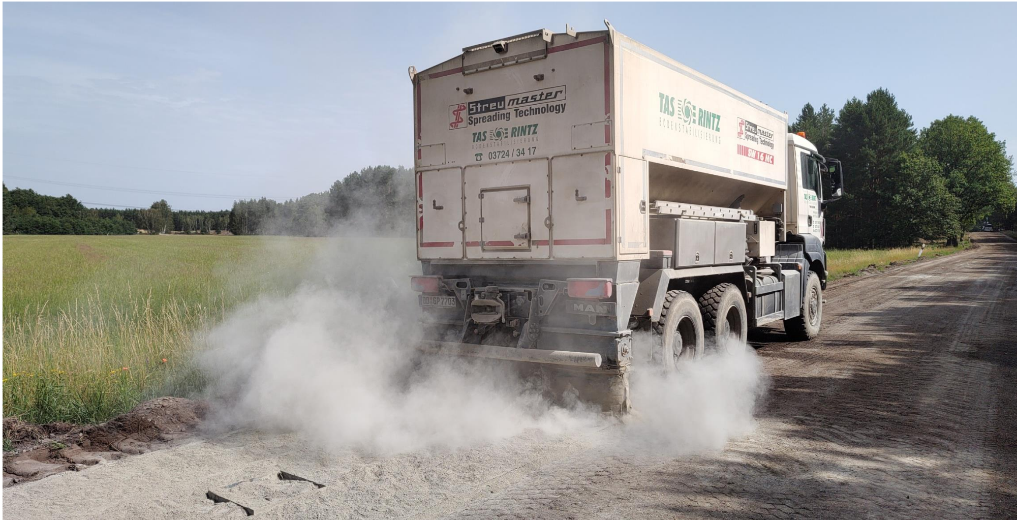
Bindemittel NovoCrete St 98 vorstreuen mittels Bindemittelstreuwagen
