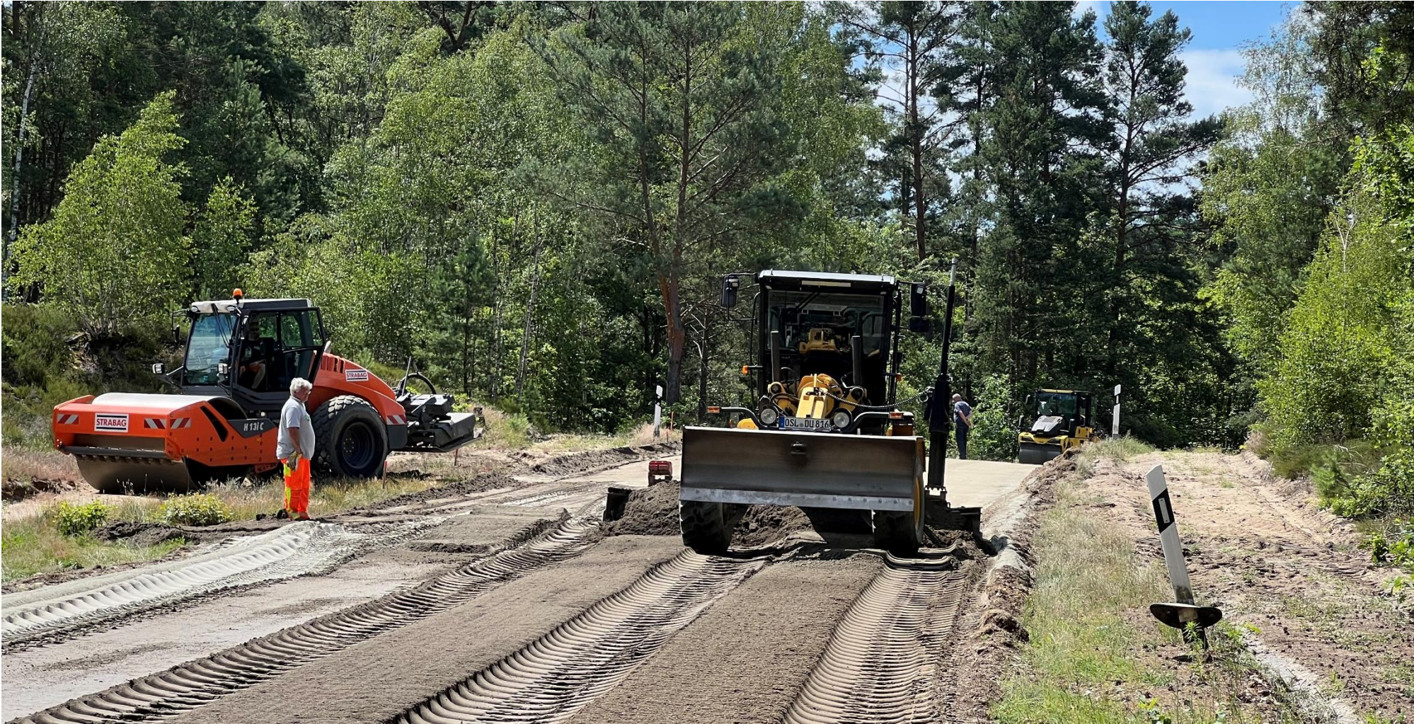
Vorprofil herstellen mittels Greader und Walze
