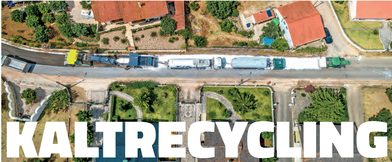
Kaltrecycling einer Landstraße in Portugal.
