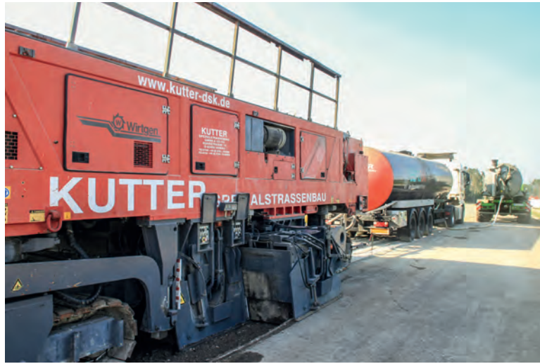
KRC Einbauzug mit vorgeschalteten Bitumenemulsion- und Wassertankwagen
