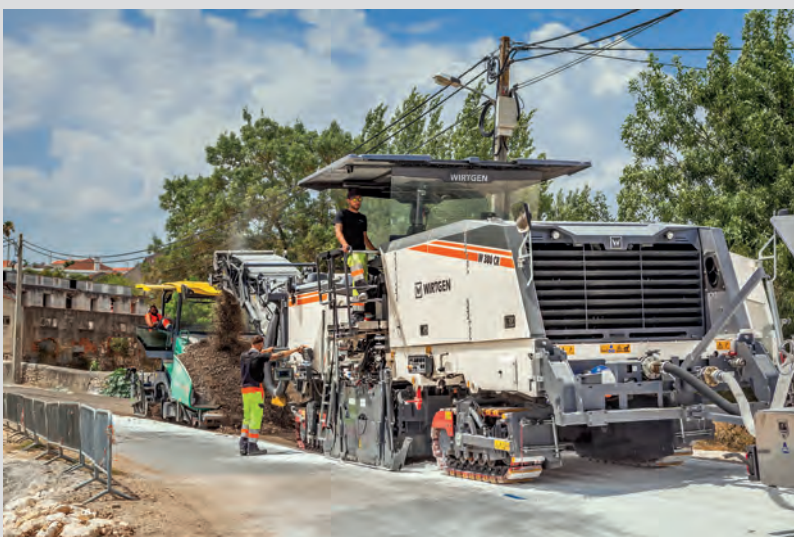
Das bei der Überfahrt hergestellte Recycling-Mischgut wird vom Kaltrecycler (hier: W 380 CRi) über eine integrierte Heckverladung direkt an einen Einbaufertiger übergeben. Er baut das sehr homogene Mischgut unmittelbar dahinter profil- und lagegerecht ein.
