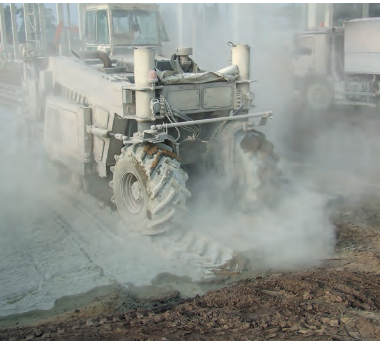
Hohe Staubentwicklung beim Einbau konventioneller Bindemittel
