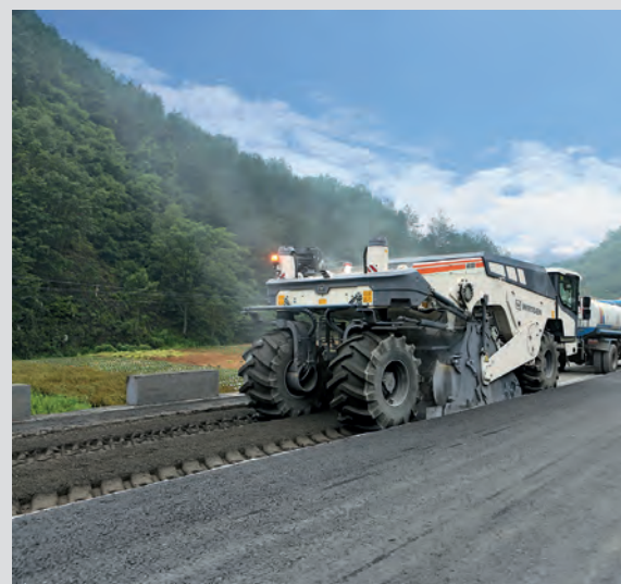
Kaltrecycling mit Bitumenemulsion und
