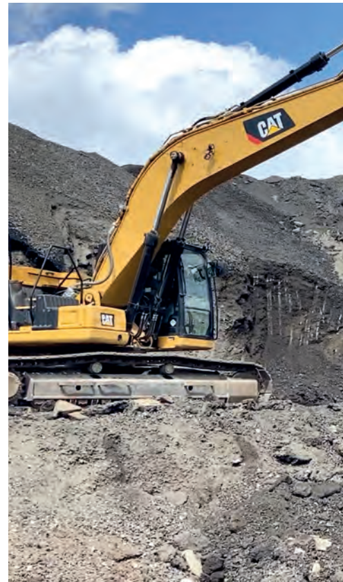
Aufbereitung des Ausbaumaterial auf eine Korngröße von max. 32 mm
