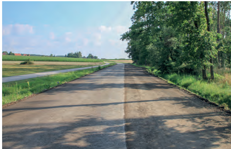
Links - fertiggestellte KRC – Schicht kurz nach Erstellung und bereits fertig zur Überbauung
