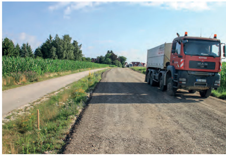
Ausstreuen des hydraulischen Bindemittels auf die vorbereitete Unterlage
