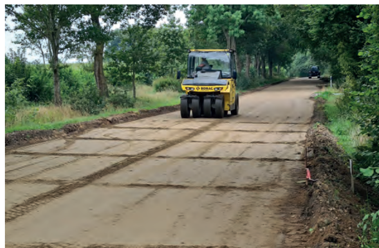
Finish mit Gummiradwalze und Kerben
