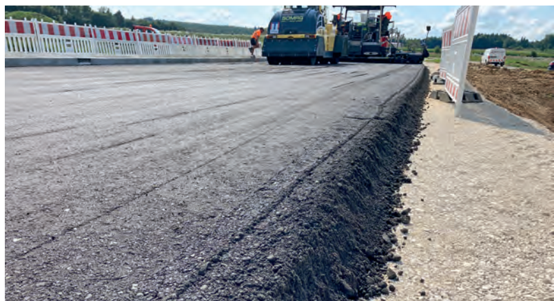
Einbau und Verdichtung – ohne Anforderungen an die Einbautemperatur
