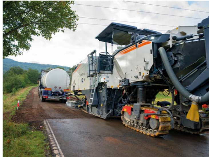
Kinderbeuern: Der Kaltrecycler W 240 CRi nutzt Schaumbitumen zur Herstellung einer hochwertigen BSM-Tragschicht.
